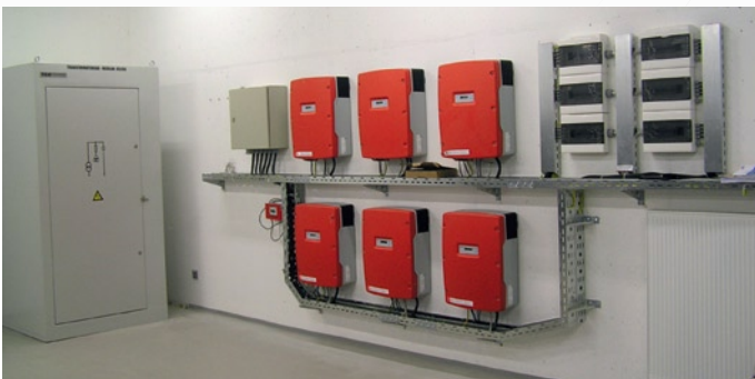
Samostojna otočna sončna elektrarna moči 1,56 kWp (zgoraj) Energetski prostor za sončno elektrarno (spodaj)
