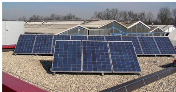
Sončna elektrarna na strehi podjetja Arcont v Gornji Radgoni z močjo 2,58 kWp
