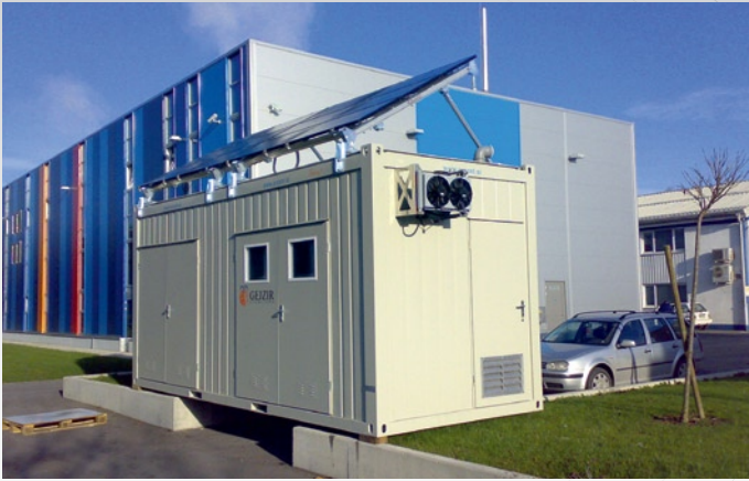
Samostojna otočna sončna elektrarna moči 1,56 kWp (zgoraj) Energetski prostor za sončno elektrarno (spodaj)
